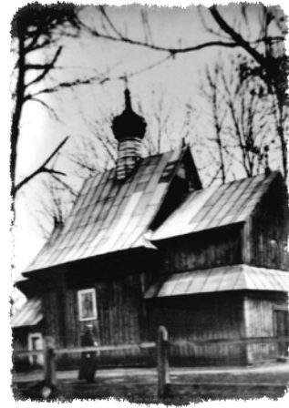
Разрушенная в 1938 году церковь в Вакиёве
