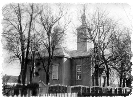
Разрушенная в 1938 году церковь в Ласкове
