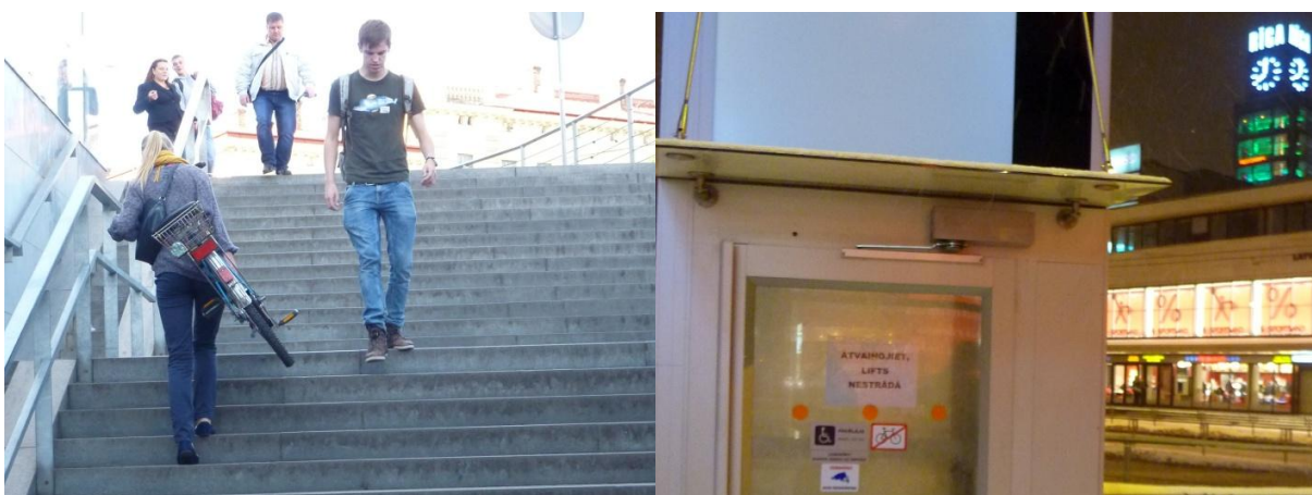
20. attēls Centrālās dzelzceļa stacijas tunela trepes un lifts ar regulāro uzrakstu „Atvainojiet, lifts nestrādā” (Autores foto, 2013)
