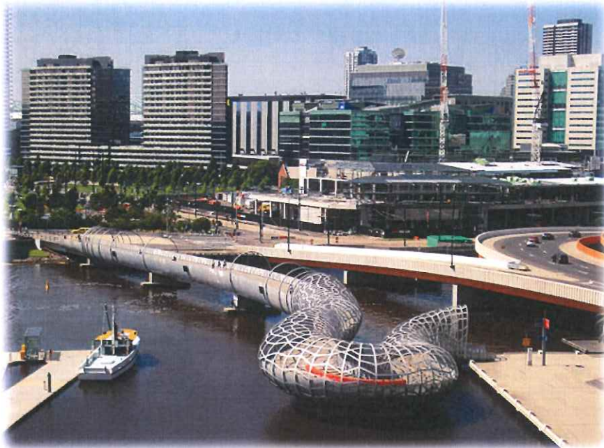
31.attēls. Kopskats uz pinuma tiltu diennakts gaišajā laikā (attēla avots: http://melbournedaily.blogspot.com/2012/08/webb-bridge-docklands.html )
