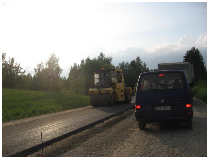
8. attēls. Autoceļa P62 rekonstrukcija (N.Otvares foto)
