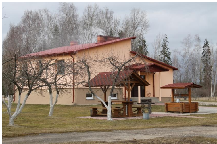
3. attēls. Renovētā dzīvojamā māja "Saides" Dēgļu ciemā (N.Otvares foto)
