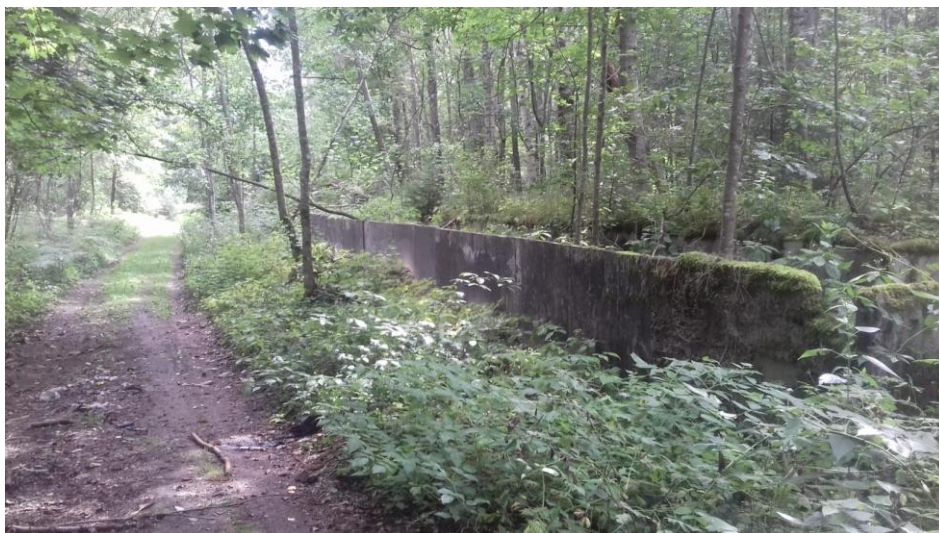
4.66. attēls. Stigas ielas posms 2019. gada vasarā (foto: L. Kačkāne 2020)
