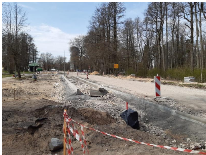
4.61. attēls. Skats uz remontdarbiem pie Ķemeru parka (foto: L. Kačkāne 2020)
