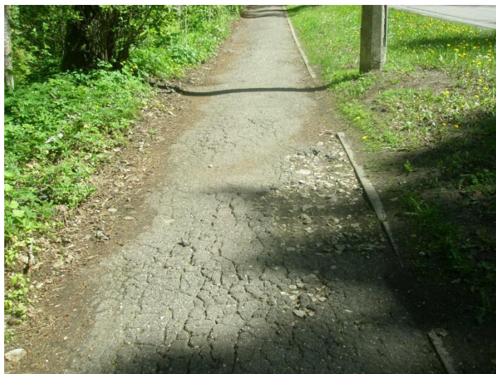
4.69. attēls. Pazeminātas kvalitātes asfaltētā gājēju ceļa segums (foto: L. Kačkāne 2020)
