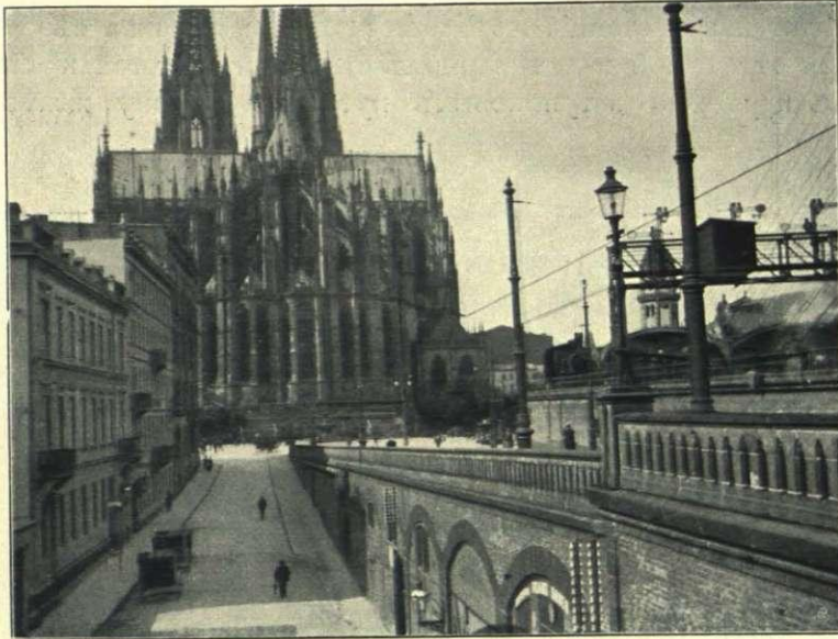
Подъемъ къ мосту черезъ р. Рейнъ.
