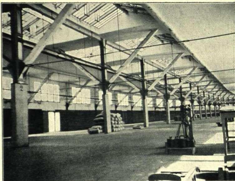
Новый пакгаузъ внутри.
