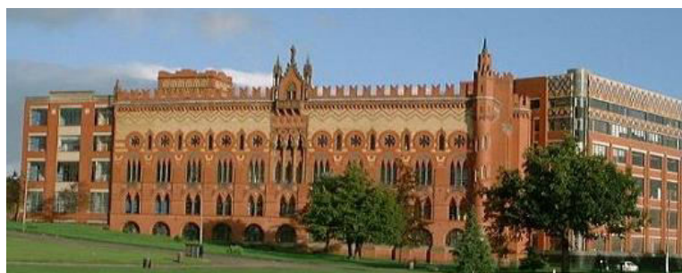
1.4.att., Paklāju fabrikas ēka Sansusī
