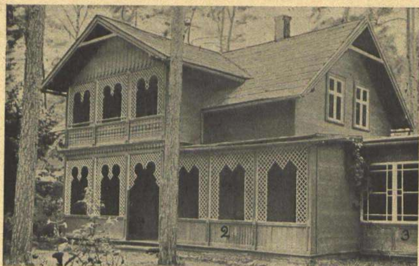
73. Vasarnīca ar drempeļi un piebūvētām, režģiem rotātām, vaļējām verandām. Būvēta ap 1875. g., 2. un 3. būvētas vēlāk.
