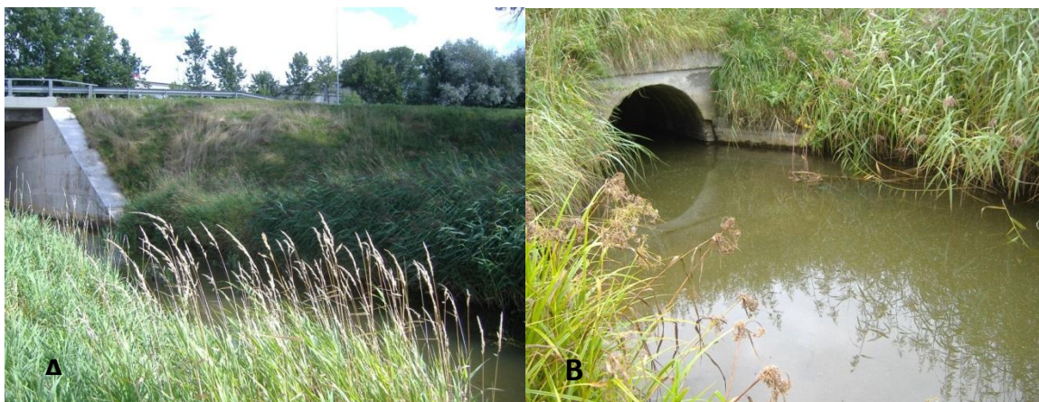
5.4.3. attēls. Upes modifikācijas pazīmes: A-nostiprināts krasts un B-drenāžas caurule (autora foto)
