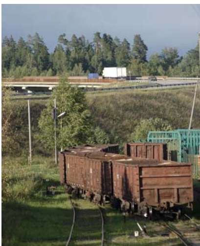
3.3. attēls. Infrastruktūra – dzelzceļa atzars uz Bebruleju un valsts nozīmes šoseja A6 (E22)
