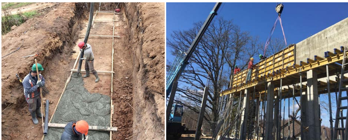
3.3. att. SIA „Jēkabpils PMK” darbiniekiem būvniecības procesā
