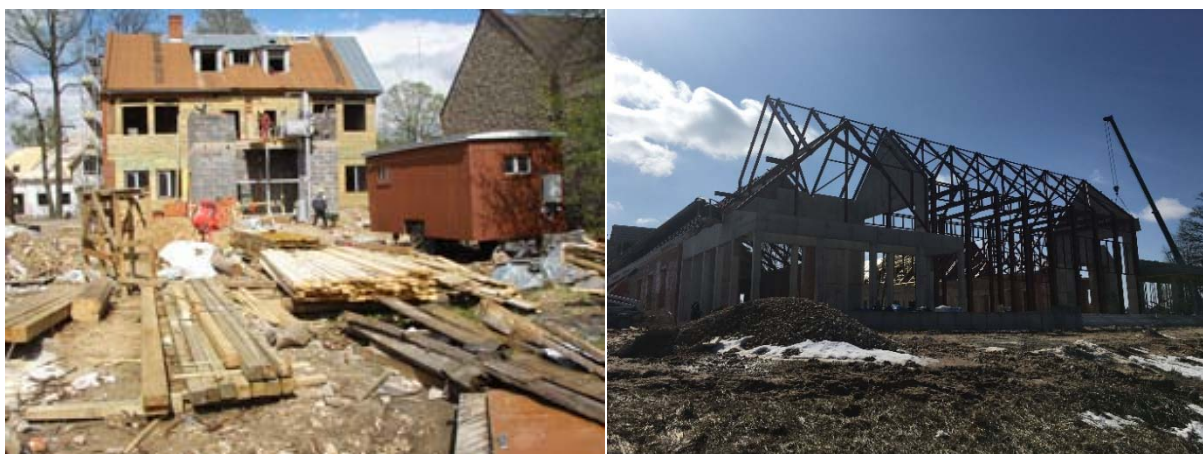
3.2. att. SIA "Jēkabpils PMK" būvniecības objekti.
