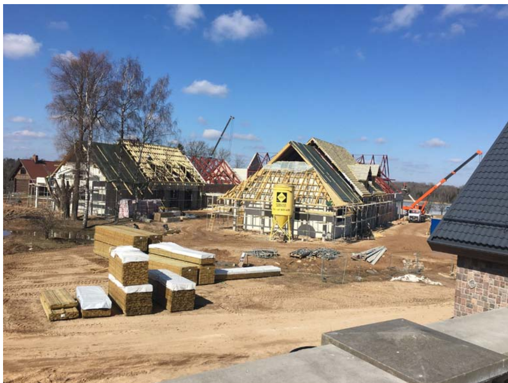
3.26.att. Būvobjekts, kurā tika veikta fiziskās slodzes analīze montētājiem un būvstrādniekiem
