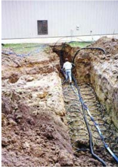
1.6.attēls.Ģeotermālais siltumsūknis ar vertikālo siltummaini 1.7.attēls Zemes kolektors
