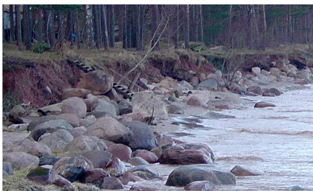
3.3.2.1.att. Krasta aizsardzība ar laukakmeņu bērumiem uz dienvidiem no Rojas ostas.
