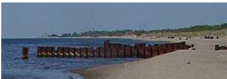
3.3.2.2.att. Krasta aizsardzībai izmantotā būna-rievsiena. Rīgā pie Rītabuļļiem. Autores foto, (2004.05.17).
