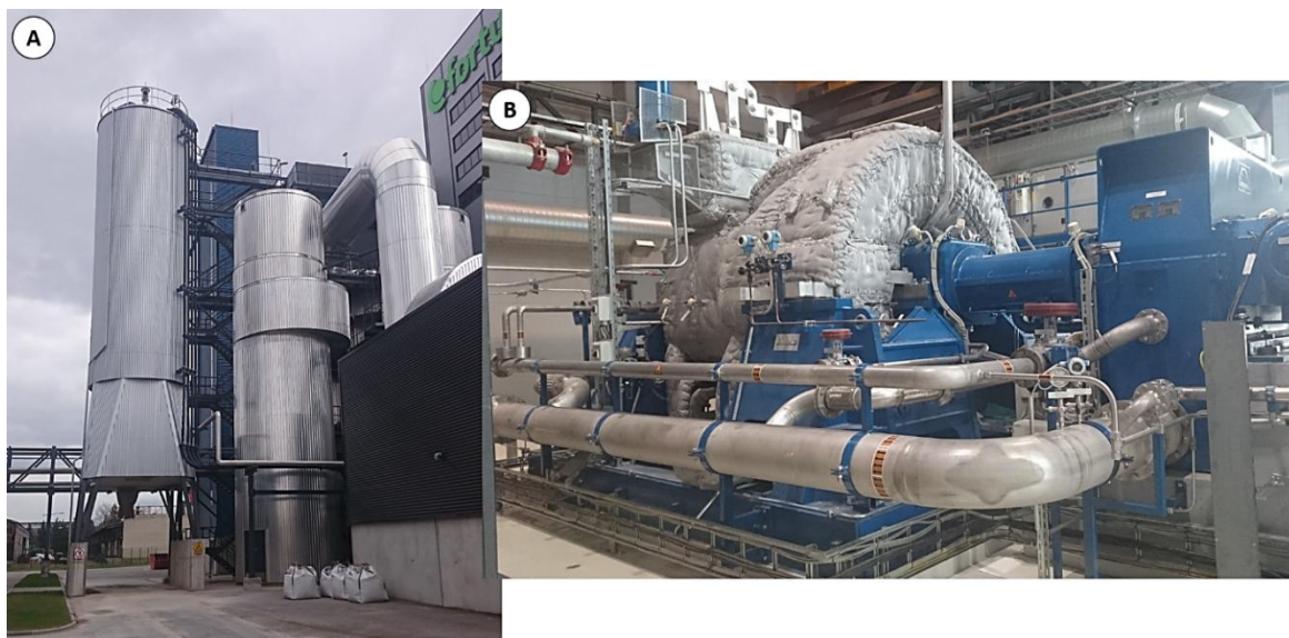
1.4. attēls. Biomāsas koģenerācijas stacija SIA „Fortum Jelgava”: a) vieglo pelnu uztvērēji; b) tvaika turbīna (autora foto)
