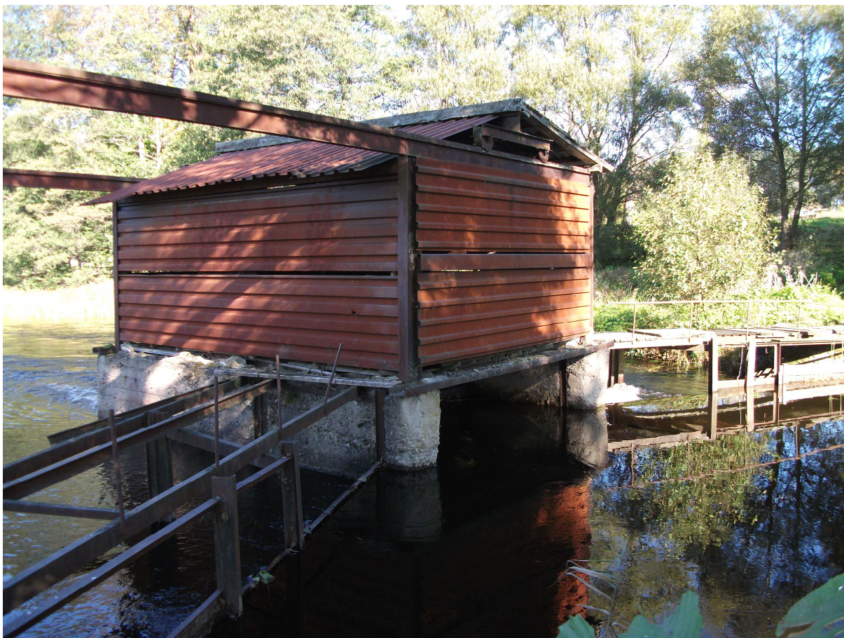
4.7. attēls. Zušu ķeramā ierīce uz Engures upes, netālu no tās iztekas no Usmas ezera (Foto: Mārtiņš Kriķītis, 2010)
