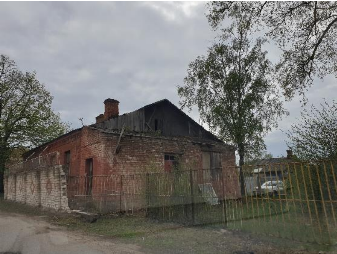
87.attēls. Ražošanas teritorijā neizmantotas ēkas, Andreja iela 105D
