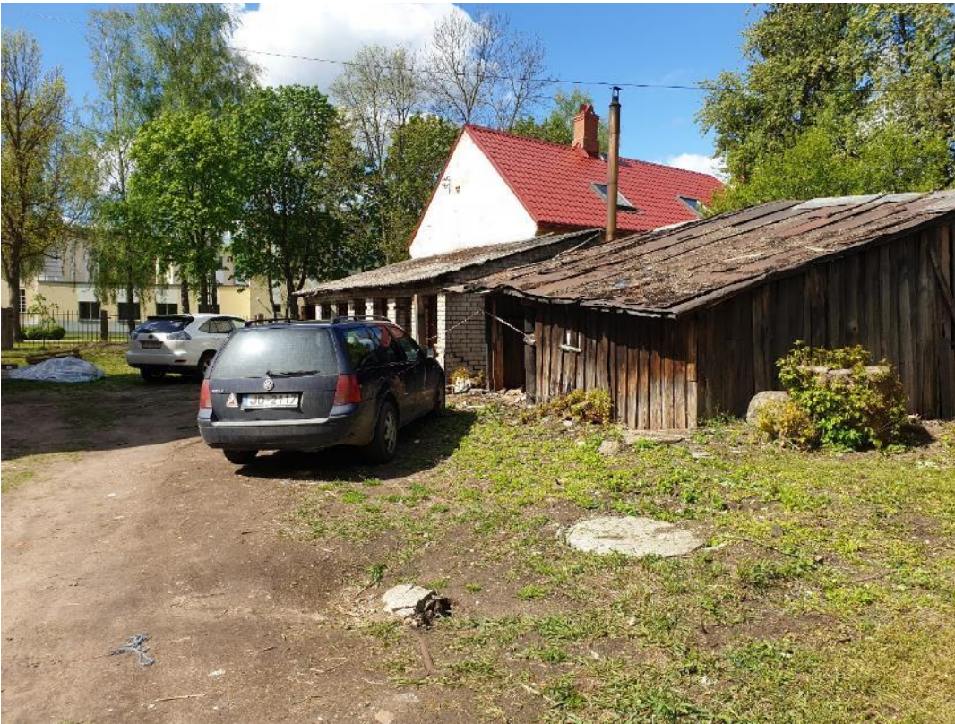
13.attēls. Neizmantotas, pamestas saimniecības ēkas Stacijas ielā 1
