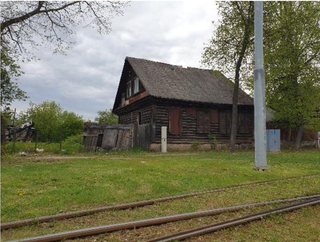
83.attēls. Neapdzīvota ēka Ventspils ielā 117
