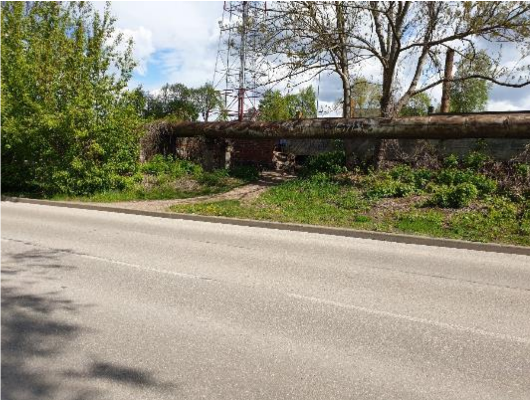
14.attēls. Bīstama, patvaļīgi izveidota dzelzceļa sliežu pāreja uz Jaunbūves apkaimi
