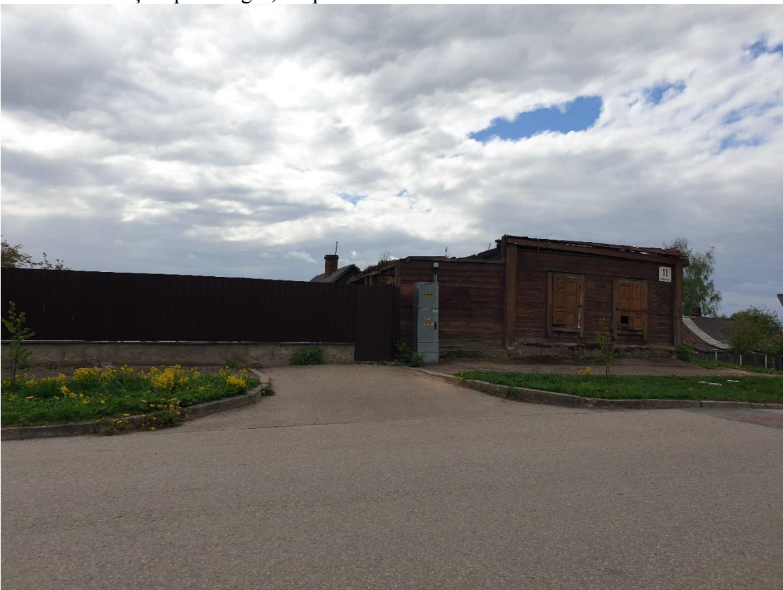
66.attēls. Bīstama ēka, Bauskas ielā 88
