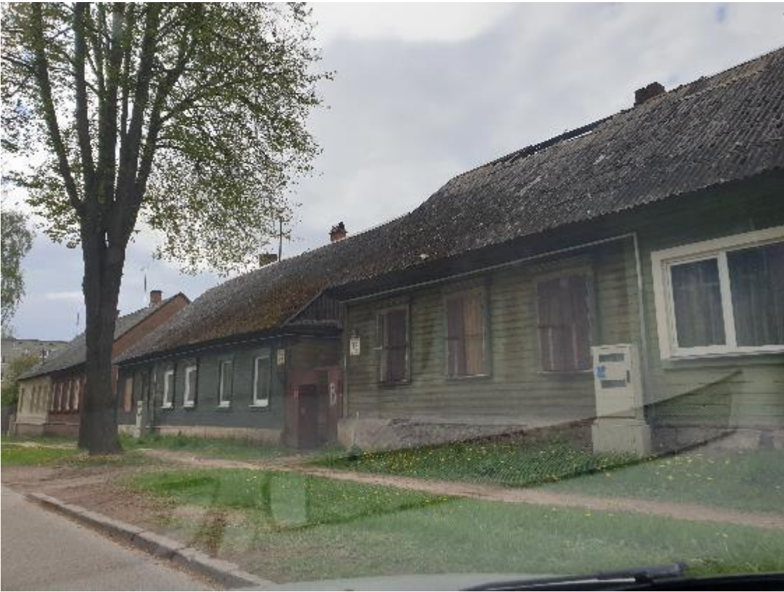
69.attēls Daļēji apdzīvota ēka, Tautas ielā 75
