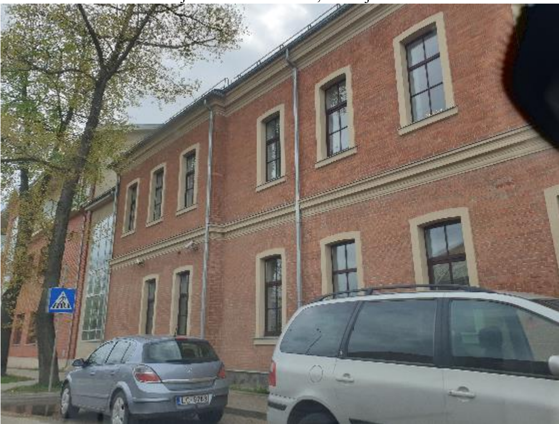
88.attēls. Atjaunotas un jaunas ēkas uzbūvētas Valsts Robežsardzes vajadzībām, Andreja Pumpura ielā 105B
