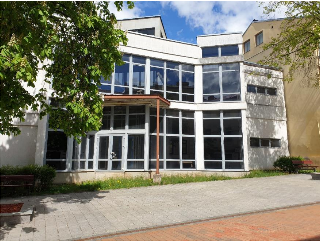
25.attēls Jaunbūve, kas netiek izmantota, Rīgas ielā 79
