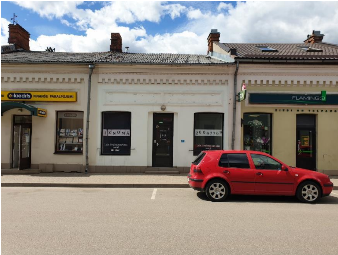
21.attēls. Neizmantotas telpas, Alejas ielā 89
