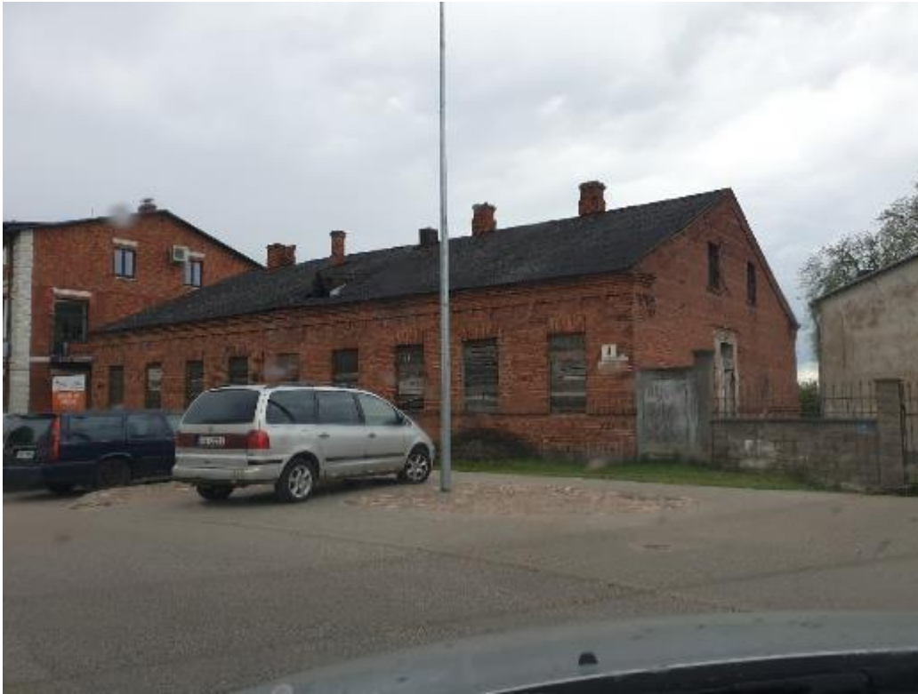
39.attēls. Neapdzīvota ēka Mazā dārza ielā 3
