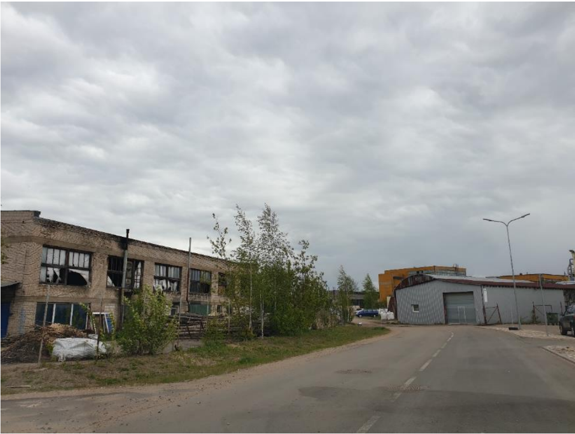
57.attēls. Neizmantota ēka, Siguldas ielā 6E
