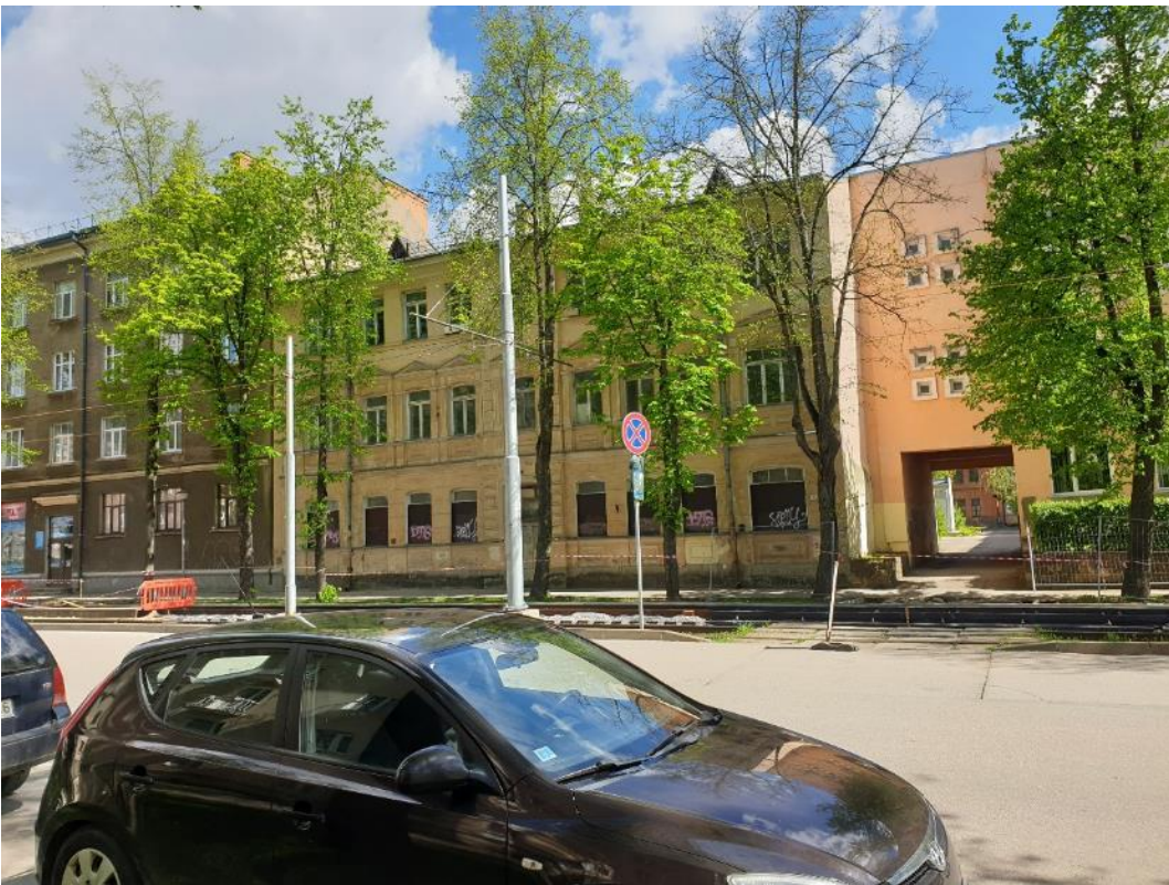
4.attēls. Neapdzīvota ēka Vienības ielā 12.
