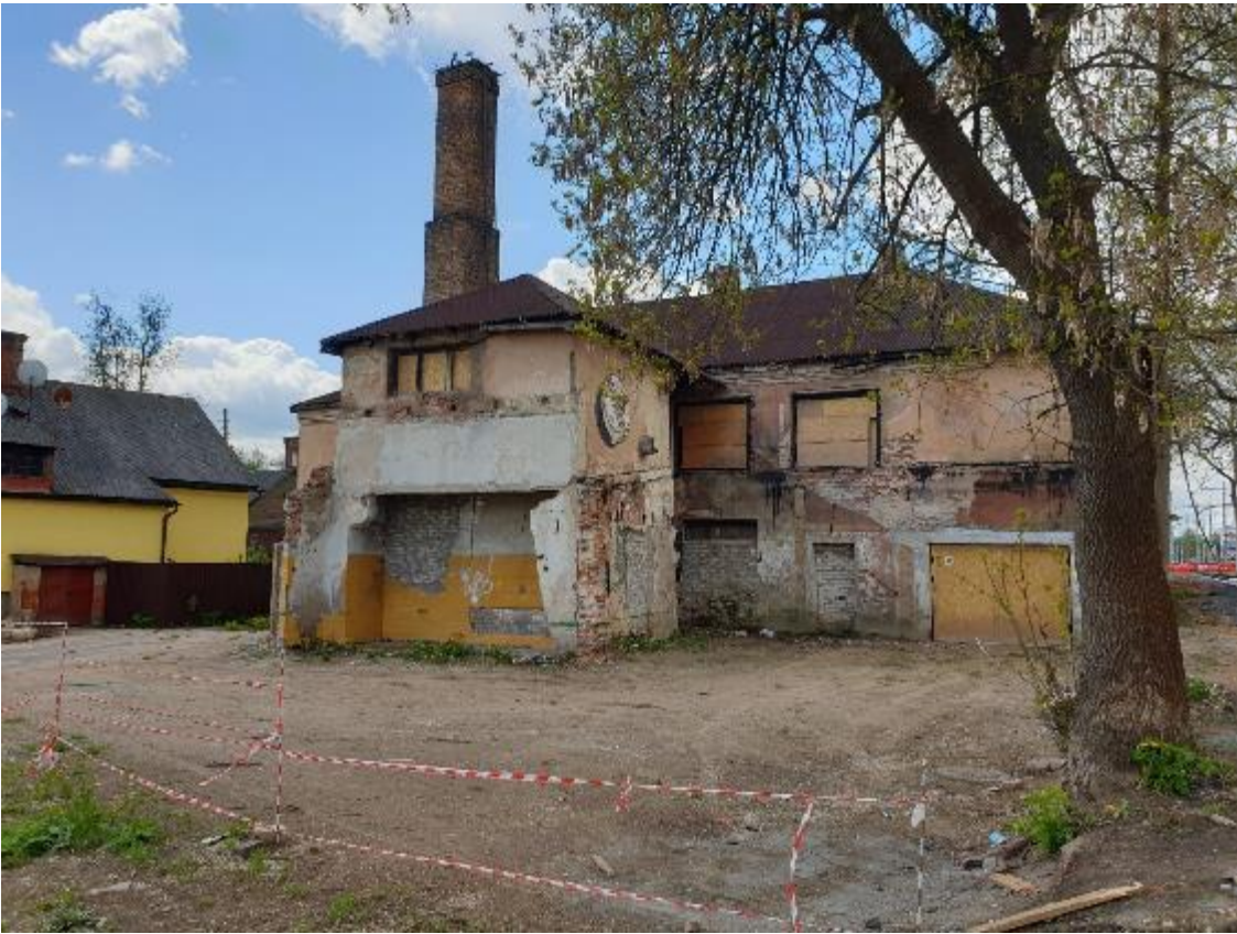
19.attēls. Degradēta ēka, Sakņu ielā 31
