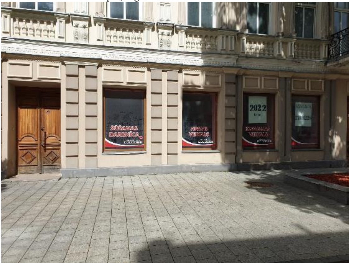
24.attēls. Neizmantotas telpas, Rīgas ielā 75
