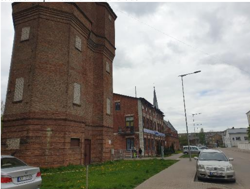
40.attēls. Slēgta būve Mazā dārza ielā 7
