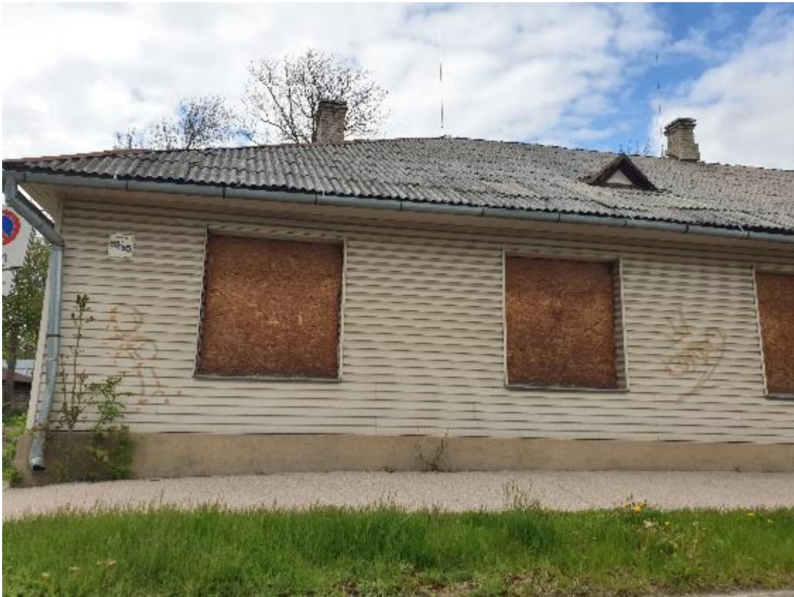
79.attēls. Neizmantota ēka, Jātņieku ielā 53
