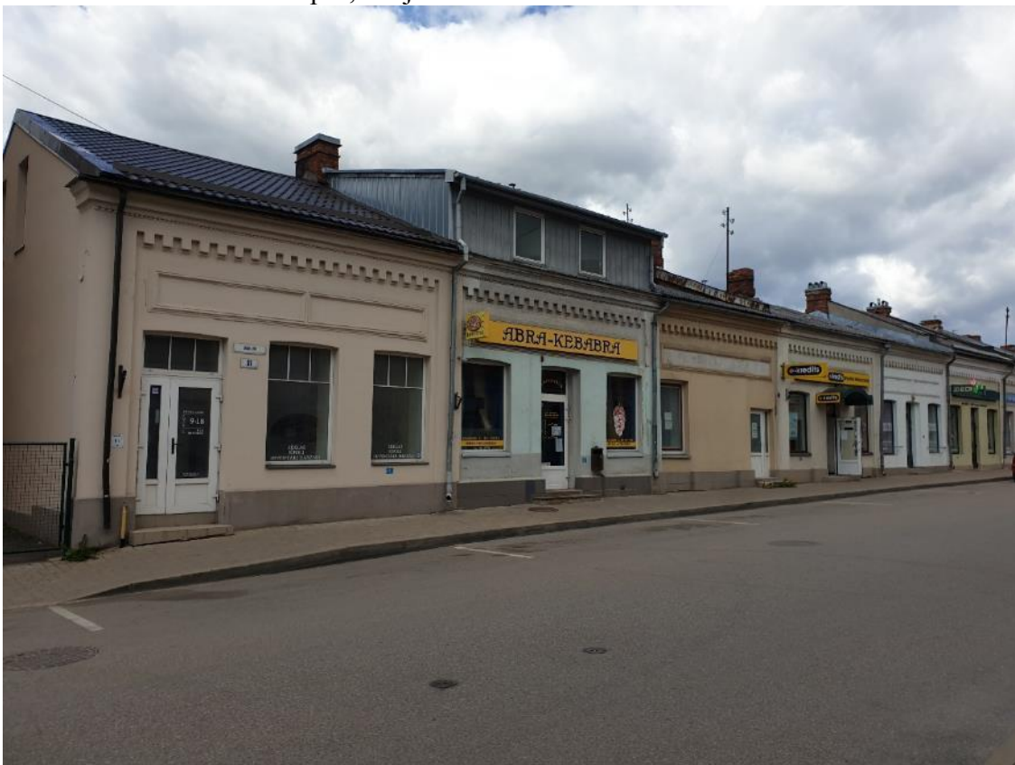
22.attēls Neizmantotas telpas, Alejas ielā 81
