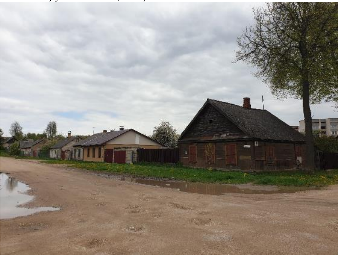
60.attēls. Neapdzīvota ēka Bauskas ielā 72
