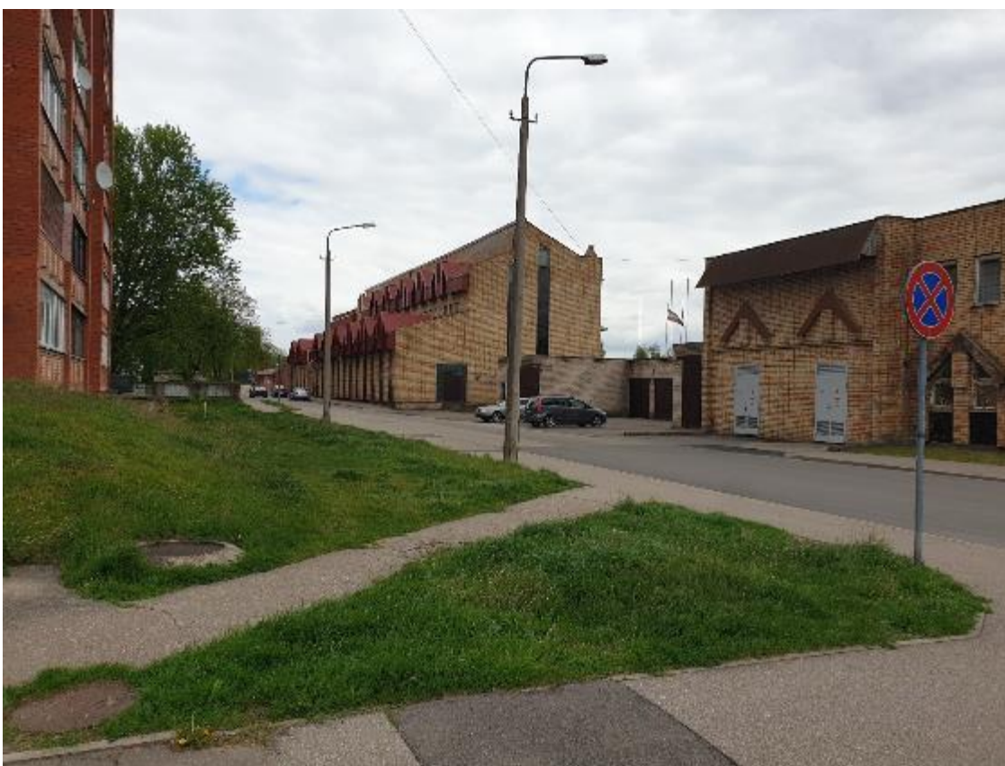
51.attēls. Sporta komplekss "Celtnieks" Jelgavas ielā 7
