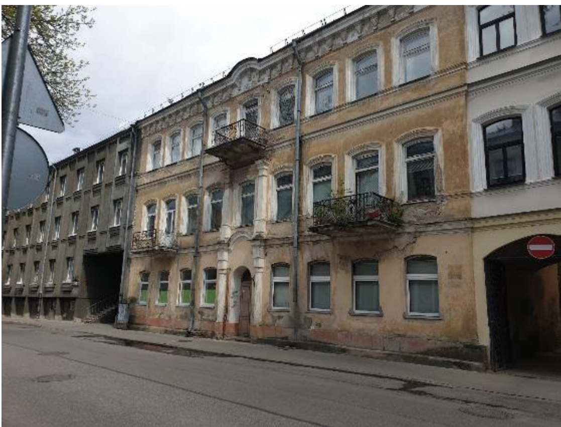
35.attēls Daļēji apdzīvota ēka Teātra ielā 26
