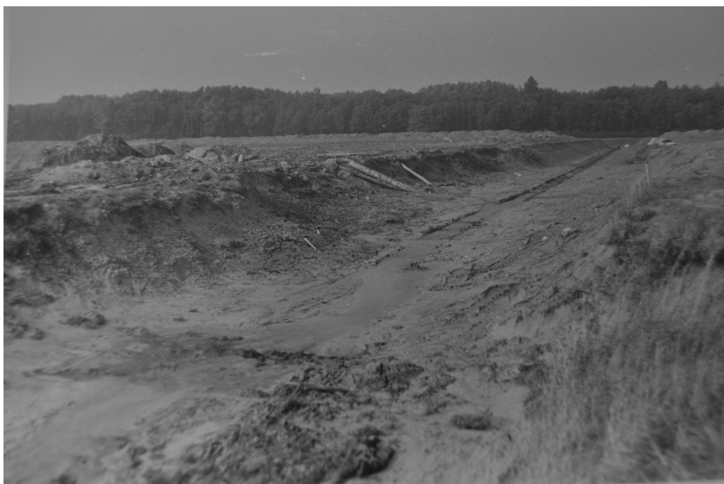
3.11 attēls. Ķūļciema poldera krājbaseina izveide 1986. gads. (Latvijas lauksaimniecības muzeja “Kalēji” arhīva materiāli, 2014)
