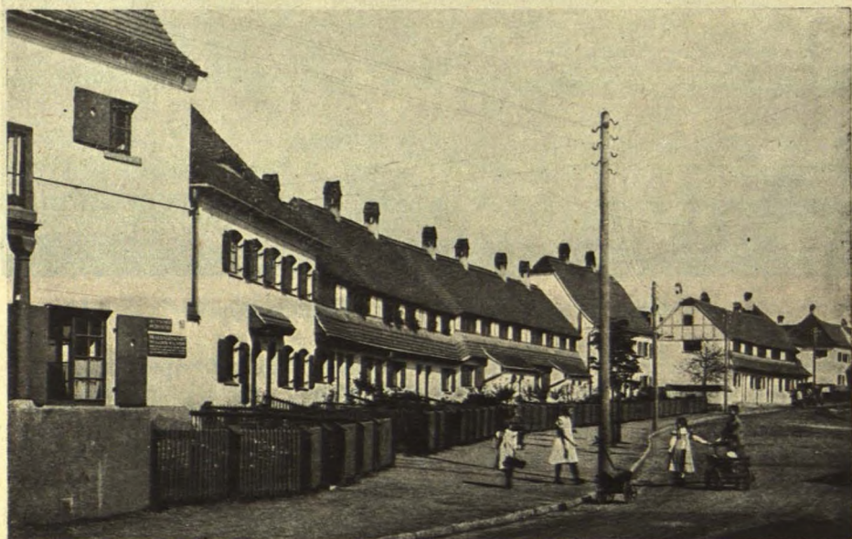
Черт. 48. Улица въ Геллерау. отношеніи, такъ какъ уже при 4-этажныхъ домахъ лучи солнца въ
