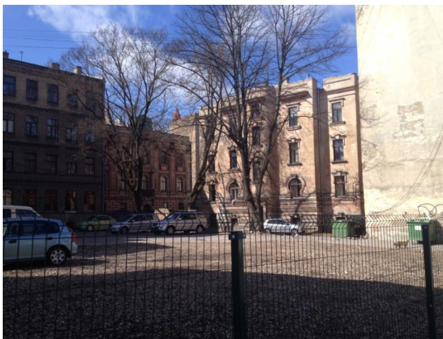
4.10. attēls. Dzirnavu iela 20 pēc ēkas demontāžas (Avots: autores foto, 2015)
