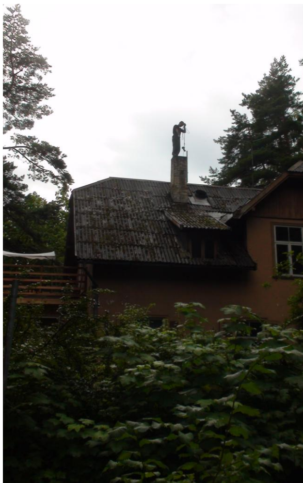
1.4. att. Skursteņa tīrīšana no augšas, izmantojot virvē iesietu birsti ar atsvaru [Avots: autora personiskais fotoarhīvs]
