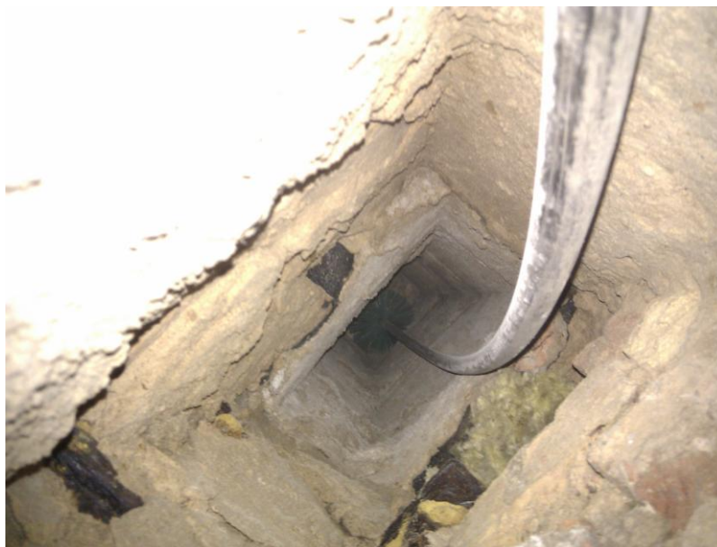
1.3. att. Skursteņa tīrīšana no lejas, izmantojot birsti un teleskopisko kātu [Avots: autora personiskais fotoarhīvs]
