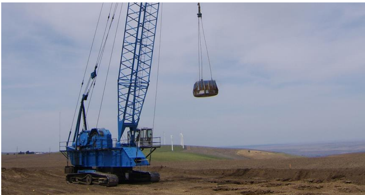
2.5. attēls. Dinamiskā blīve darbības procesā (Lampsoncrane 2012).
